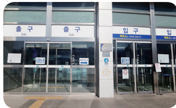
중앙홀 출입구(정문, 후문) 자동문 설치를 통해 휠체어사용자 이동편의 증진
