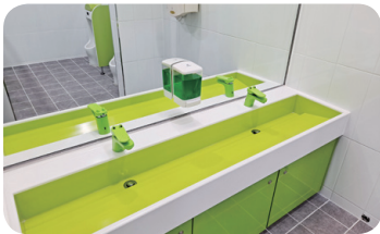
어린이 신체 및 휠체어 접근이 가능한 어린이 맞춤형 세면대 설치
