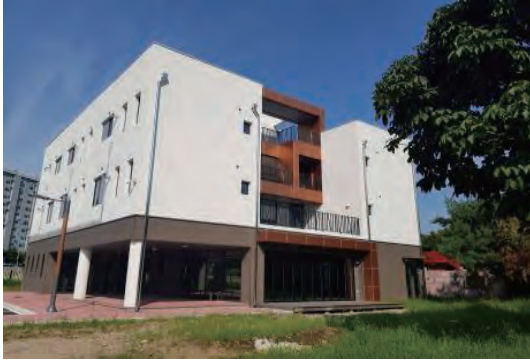
▲ 사천 용강동 거북이집 외부 전경
