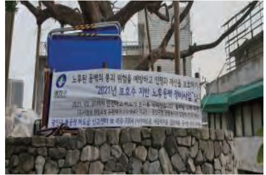
▲ 공사기간 중 공사안내 현수막
