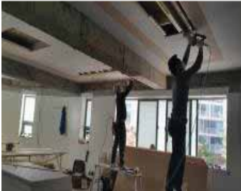
커뮤니티&도서관 천정 목공 및 전기작업
