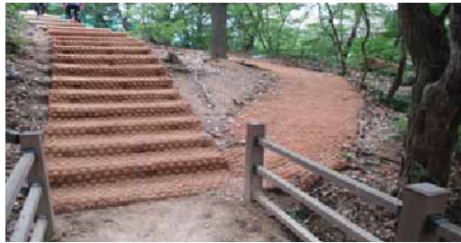
보행매트 및 무장애 진입경사로 설치
