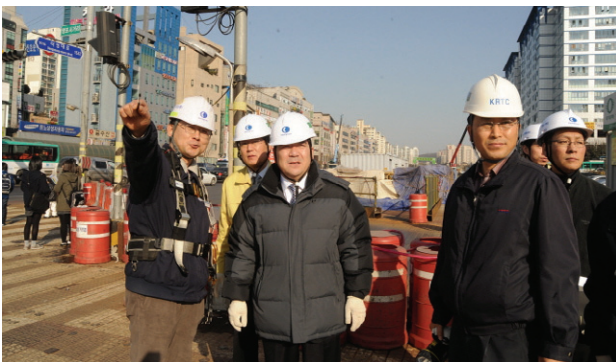
오리~수원 복선전철(4공구) 안전점검
