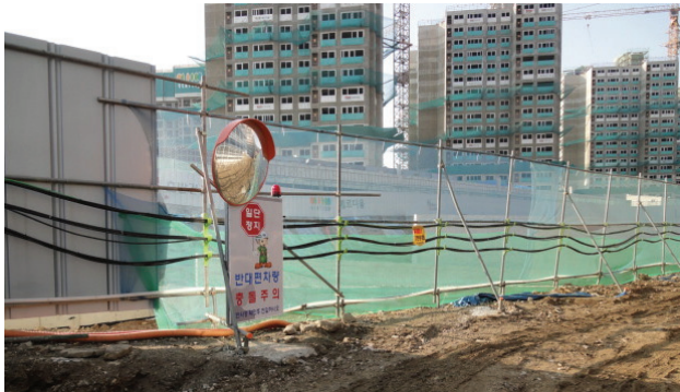
공사장내 가설도로 반사경 설치
