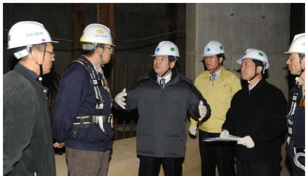
오리~수원 복선전철(4공구) 안전점검
