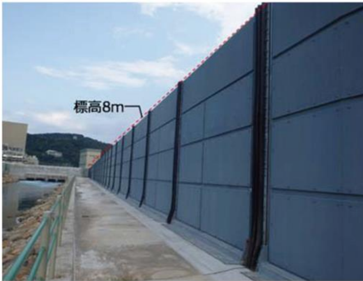
다카하마 원전의 방파제
