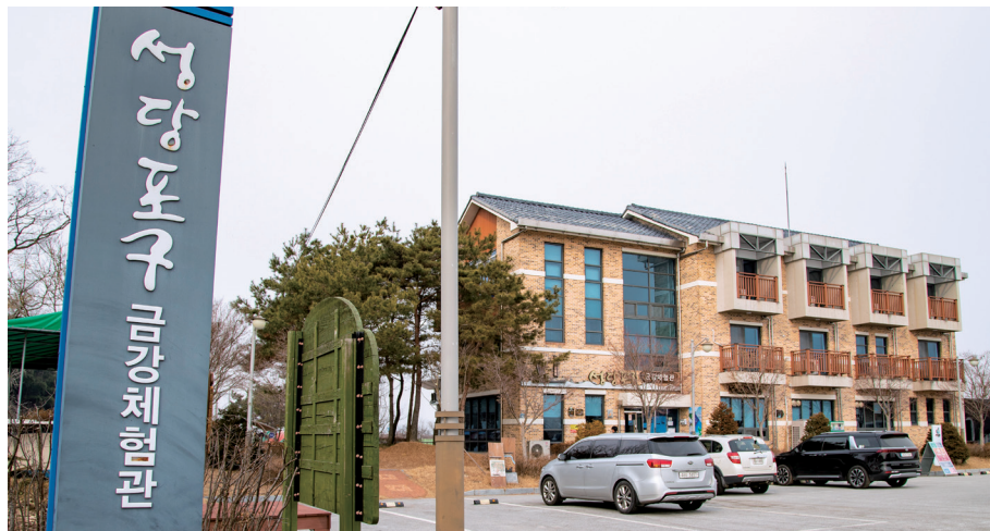
태양광 설비가 설치된 성당포구 금강체험관 전경
