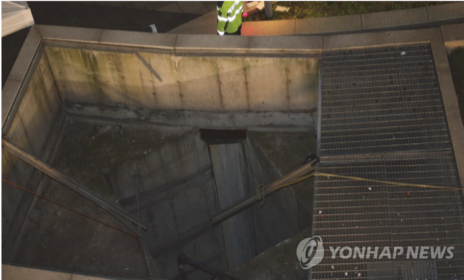
[그림 3-15] 판교 야외공연장 환풍구 붕괴사고 현장
